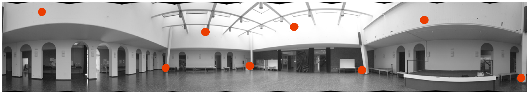
Eingangshalle der Fachhochschule
